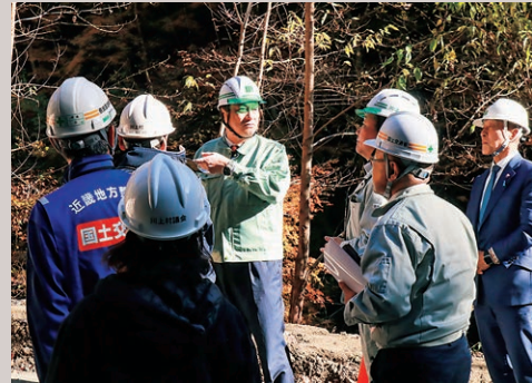
令和7年11月 川上村井光の 村道崩落現場を視察
