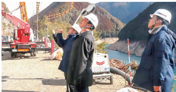
⑧令和6年2月 下北山村国道169号土砂崩れ現場視察
