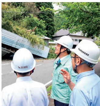
⑩令和6年7月 国道369号曾爾村地内崩落現場視察
